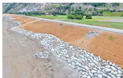
Protection contre l'érosion construction hydraulique
