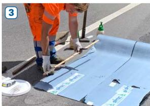
**3 Découpe:** Découpez SYTEC FlixFix® à la taille désirée afin que le FlixFix® déborde de 10 cm autour de la zone à traiter. En cas d'utilisation de plusieurs lés, il faut également veiller à ce qu'il y ait un recouvrement de 10 cm.
