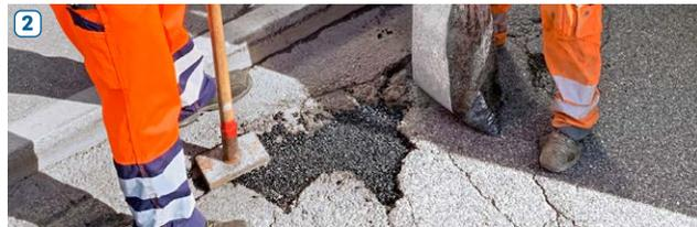
**2 Scellement:** Sceller les fissures avec du mastic. Remplissez et compactez les nids de poule avec un enrobé à froid ou chaud.
