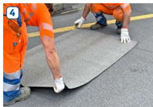
**4 Application:** Enlevez le film de l'autocollant au dos. Placez SYTEC FlixFix® sur la surface de la route à réparer et chauffer le support si besoin (température min. 25°C / max. 100°C).
