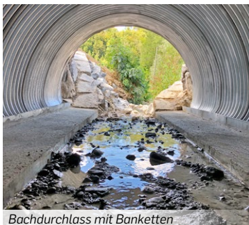
Bachdurchlass mit Banketten
