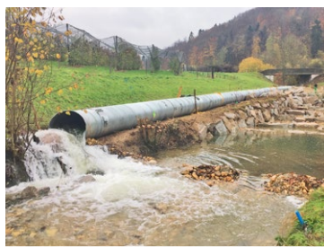
Conduite pour rivière enterrée
