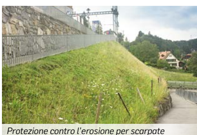
Protezione contro l'erosione per scarpate
