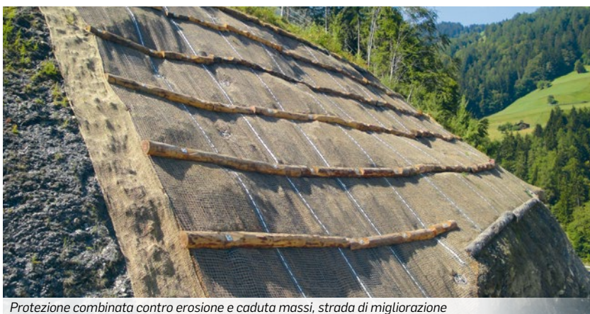
Protezione combinata contro erosione e caduta massi, strada di miglioramento
