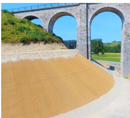
Protezione contro l'erosione per infrastrutture
