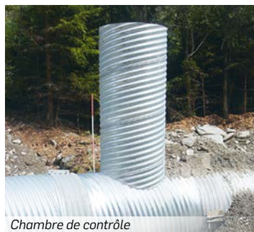
Chambre de contrôle
