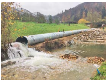
Conduite pour rivière enterrée
