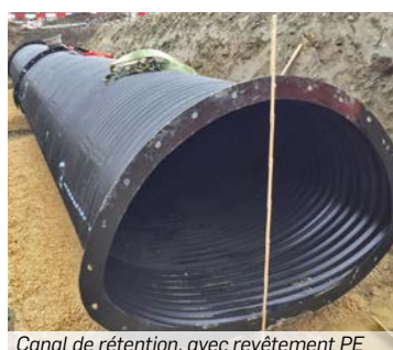
Canal de rétention, avec revêtement PE
