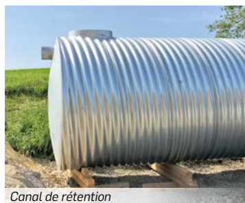
Canal de rétention
