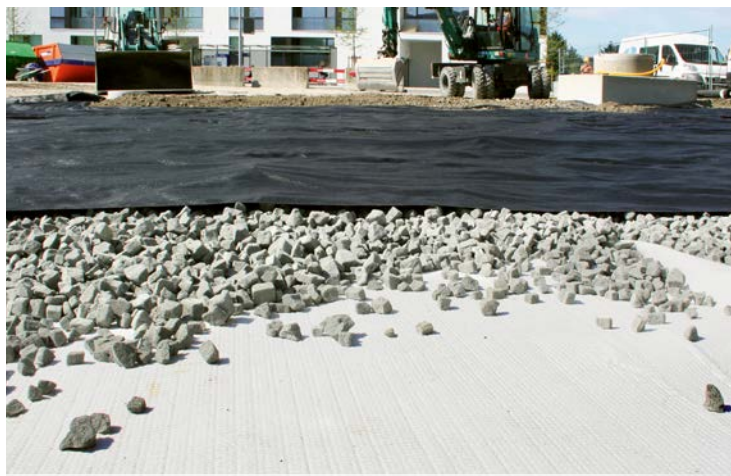
Drenaggio tetto piano
