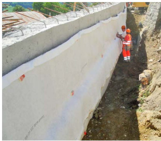
Drenaggio muro di sostegno
