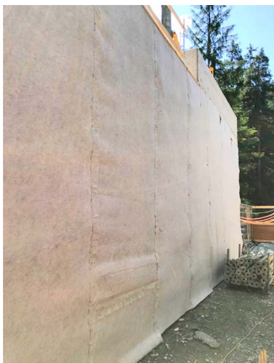
Drenaggio costruzioni sotto il livello del terreno
