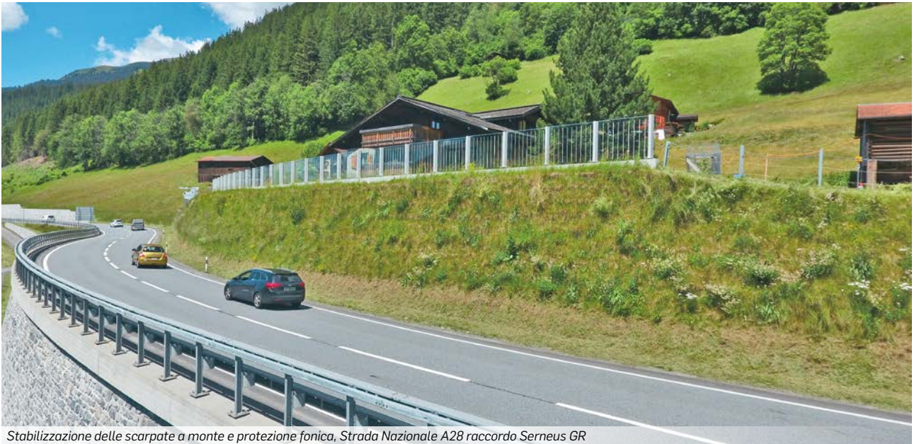
Stabilizzazione delle scarpate a monte e protezione fonica, Strada Nazionale A28 raccordo Serneus GR
