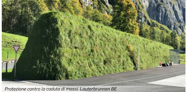
Protezione contro la caduta di massi, Lauterbrunnen BE
