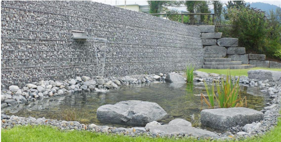
SYTEC TerraStone® Plus è un attrattivo sistema di sostegno con il fronte realizzato meccanicamente a secco oppure tramite la stratificazione di pietre naturali. Si tratta di un sistema rapido da erigere, immediatamente in grado di reggere un carico e che non richiede nessun intervento di manutenzione. SYTEC TerraStone® Plus è particolarmente indicato
