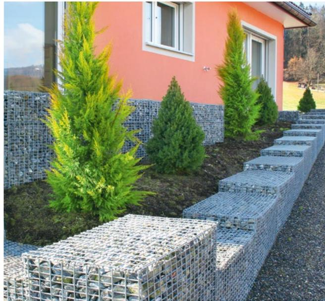
SYTEC hat die Technik der Steinkörbe zu einem perfekten, kompletten System weiterentwickelt: dauerhaft, stabil, ökologisch wertvoll, wasserdurchlässig und unterhaltsfrei. Unterschiedliches Füllmaterial und die Art, wie dieses eingelegt oder geschüttet wird, ermög-
