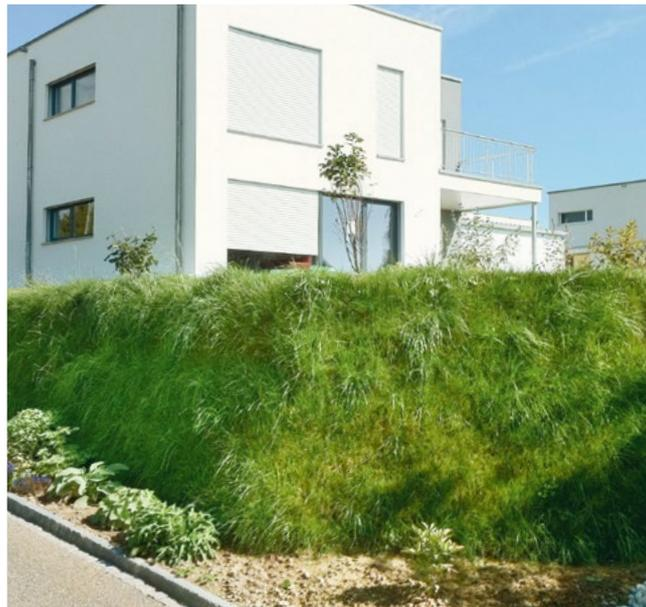
Das grüne Stützsystem SYTEC TerraMur®2 eignet sich zum Bau von Stützmauern mit natürlicher Frontgestaltung. Es passt sich optimal in die Landschaft ein. SYTEC TerraMur®2 kann in kurzer Bauzeit mit Aushubmaterial errichtet werden und ist sofort hoch tragfähig. Mit der SYTEC TerraMur®2
