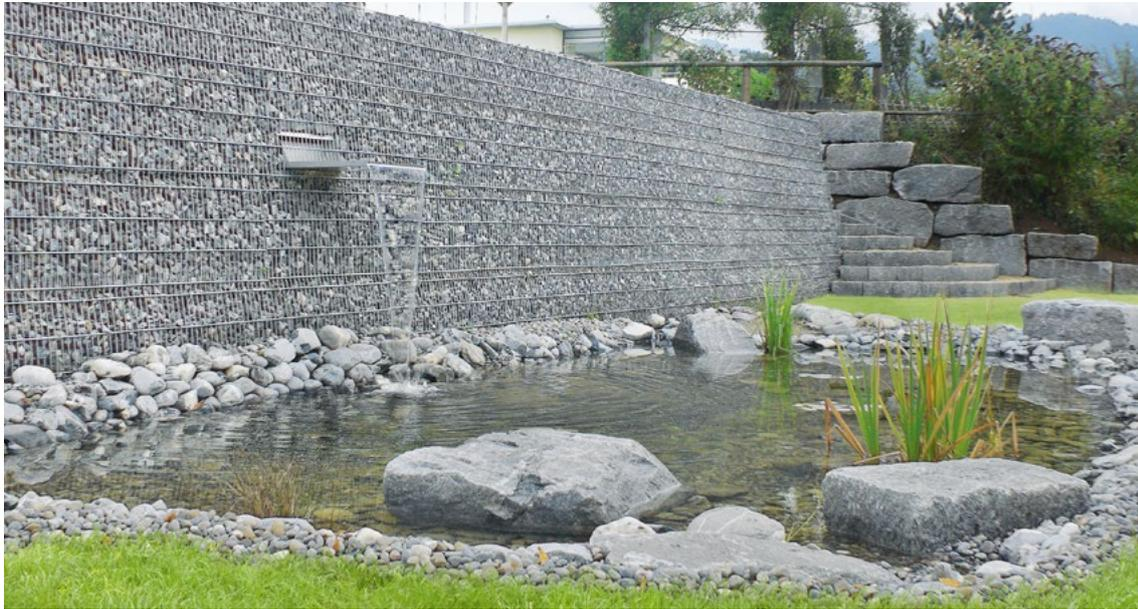
SYTEC TerraStone® Plus ist das erdbewehrte, optisch attraktive Stützsystem mit maschinell verfüllbarer Trockensteinfront oder geschichteten Natursteinen und kann in kurzer Bauzeit errichtet werden. Das Stützsystem ist sofort hoch tragfähig und unterhaltsfrei. SYTEC TerraStone® Plus ist speziell für stark
