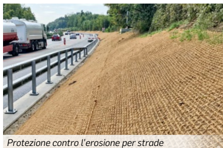
Protezione contro l'erosione per strade
