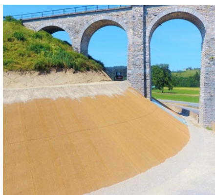
Protezione contro l'erosione per infrastrutture
