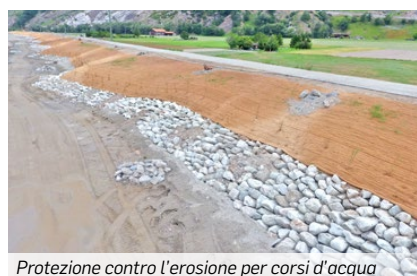
Protezione contro l'erosione per corsi d'acqua
