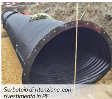
*Serbatoio di ritenzione, con rivestimento in PE*
