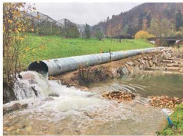
*Conduttura d'acqua di un ruscello*
